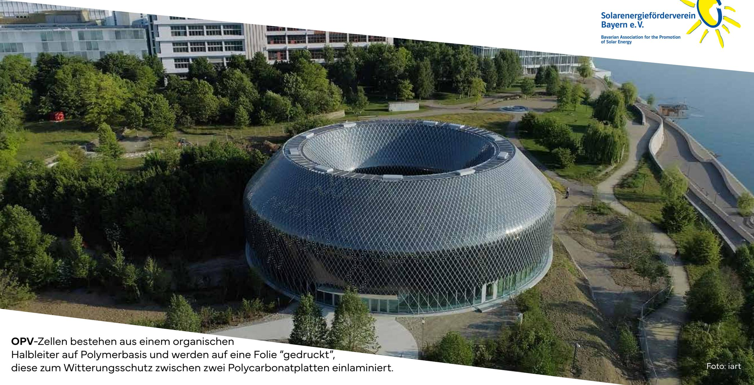
**OPV**-Zellen bestehen aus einem organischen Halbleiter auf Polymerbasis und werden auf eine Folie "gedruckt", diese zum Witterungsschutz zwischen zwei Polycarbonatplatten einlaminiert.
