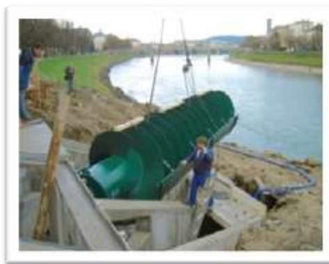
Einbau der „Wasserschnecke“ am Ausgang des Almkanals in die Salzach
