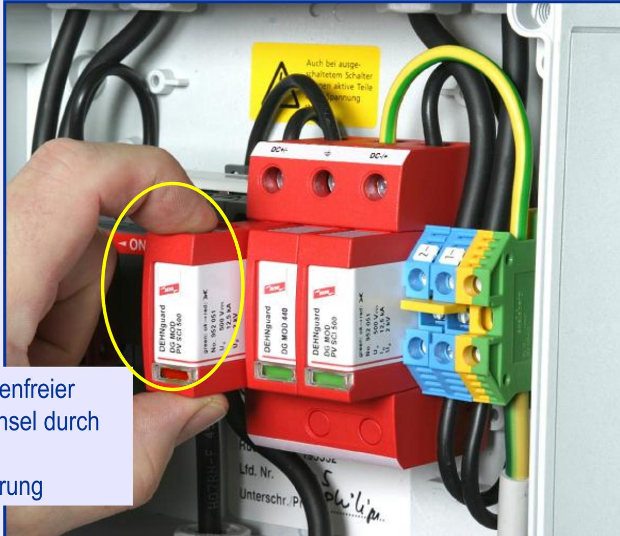
Sicherer, lichtbogenfreier Schutzmodulwechsel durch integrierte Gleichstromsicherung
