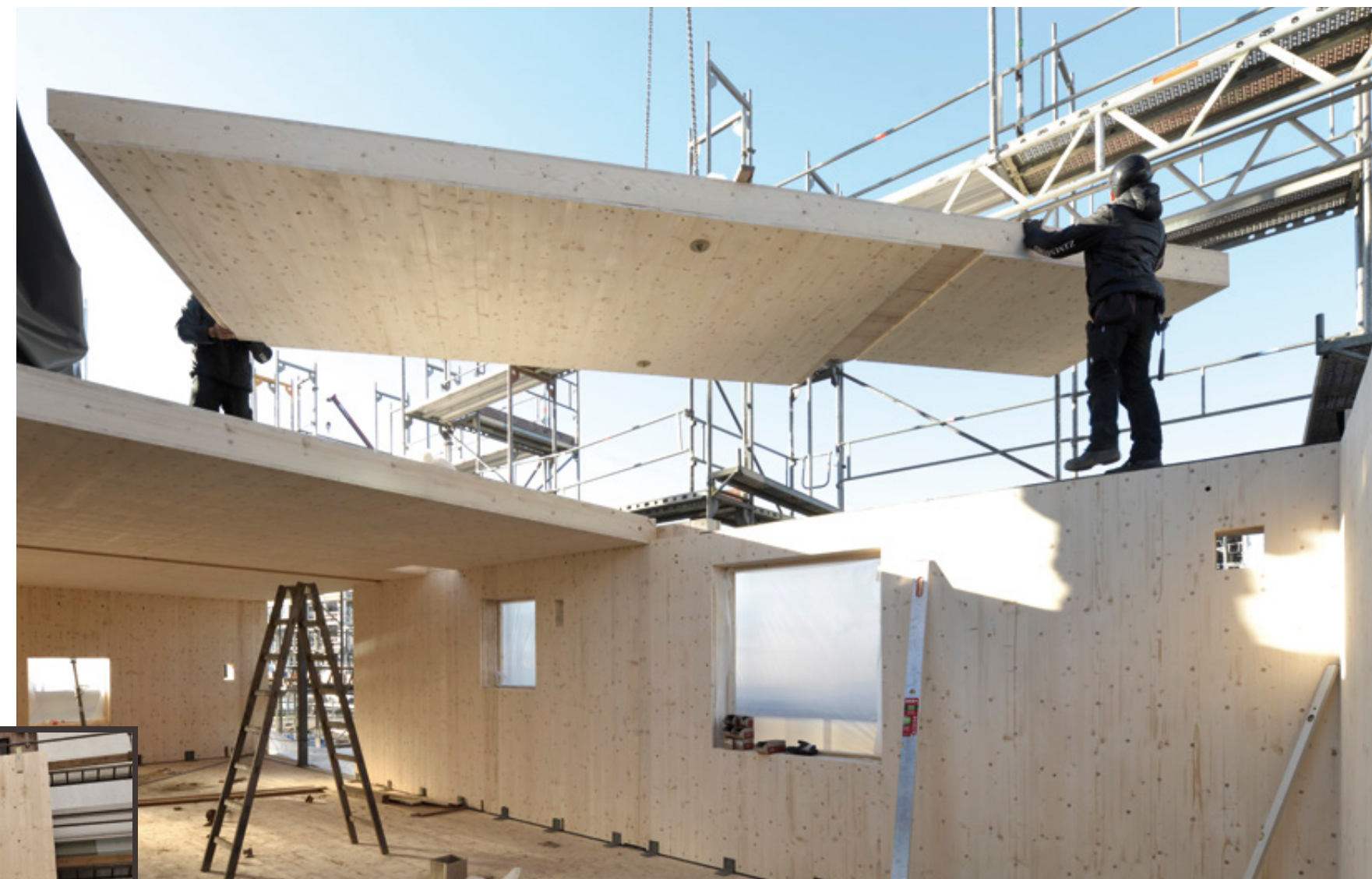
DECKENELEMENT MIT WÄRMEBRÜCKENFREIER BALKONAUSKRAGUNG. WOODCUBE HAMBURG, DEEP GREEN DEVELOPMENT GMBH, (FOTO: IBA/MARTIN KUNZE).
