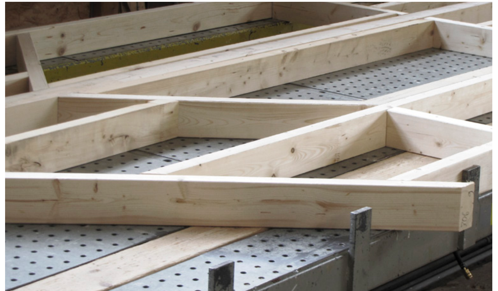
HOLZRAHMENBAU IM ABBUNDWERK.
