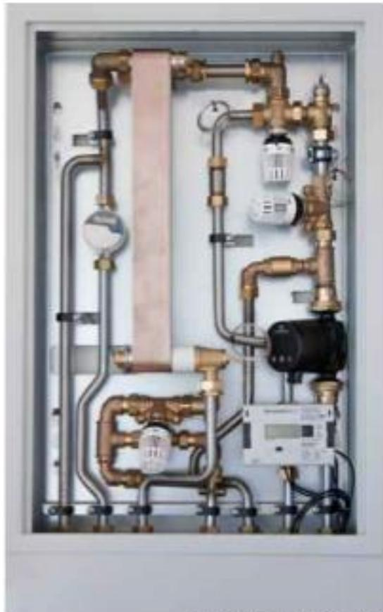
Symbolfoto „aqoLoft GHK“ mit Wärmemengen- und Kaltwasserzähler
